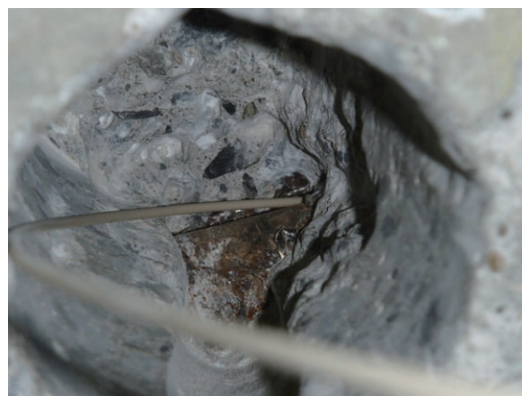
写真-6 高弾性排気チューブ挿入状況
