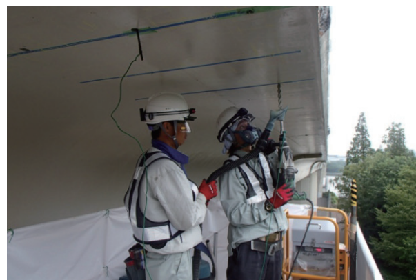
写真-3 削孔状況
