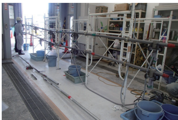
写真-4 実物大試験施工
