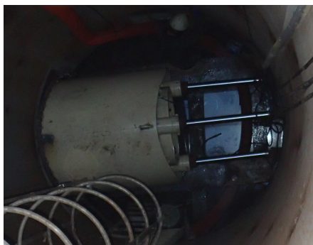
写真-4 コマンドマシンの推進状況
