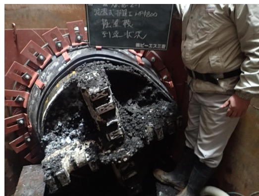
写真-7 掘進機到達状況
