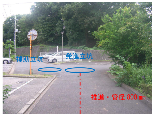
写真-1 着工前状況
