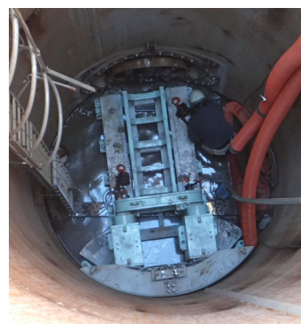
写真-5 アクロバットジャッキ
