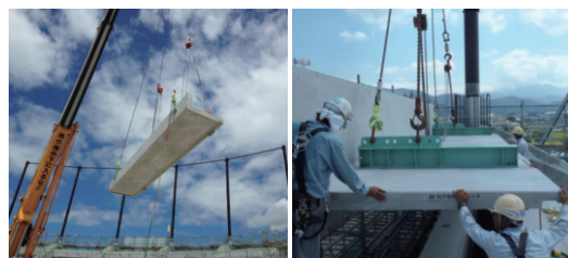
写真-4 標準タイプ・通路タイプ段床版架設状況
