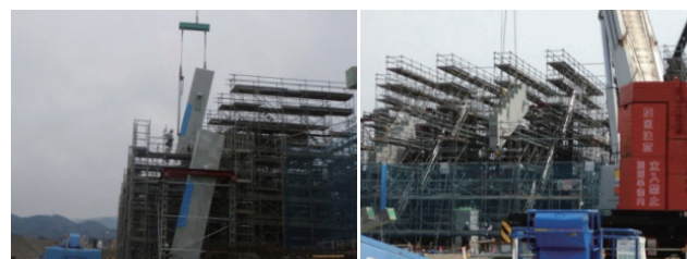
写真-3 斜め柱・段梁架設状況
