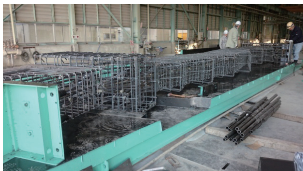
写真-2 型枠設置状況
