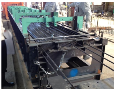
写真-9 段床版型枠設置状況
