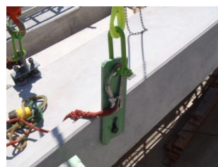
写真-22 背面吊り治具
