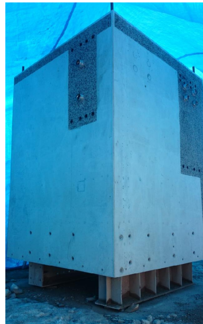
写真-6 照明塔柱仮置き状況(ブルーシート内)
