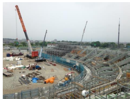
写真-12 実際の架設状況
