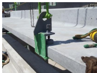
写真-21 鼻先吊り治具
