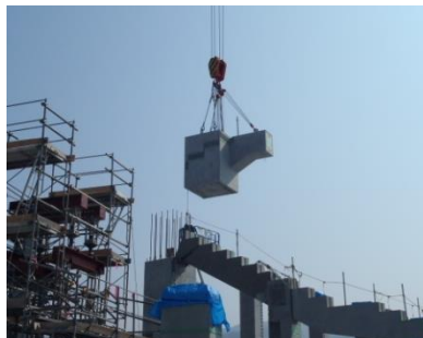
写真-13 照明塔柱架設状況
