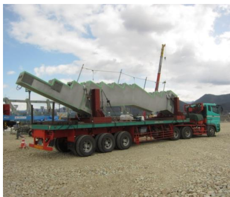
写真-19 段梁運搬時状況
