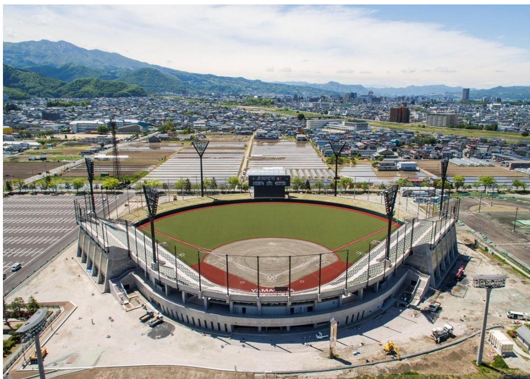
写真-2 建物全景
