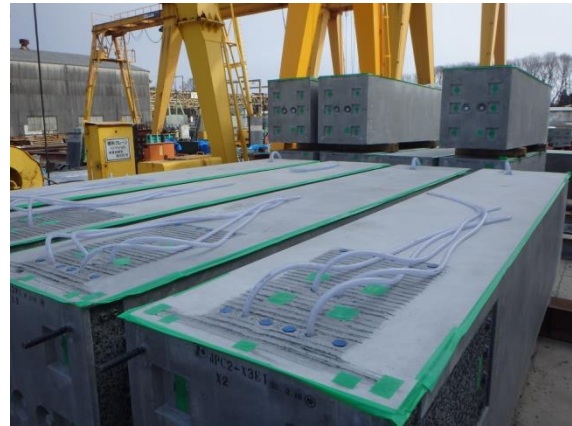
写真-4 標準柱仮置き状況
