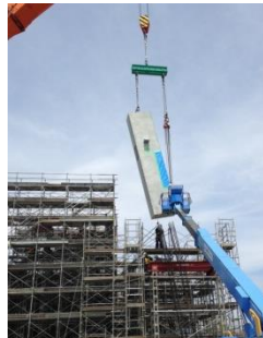
写真-14 斜め柱架設状況
