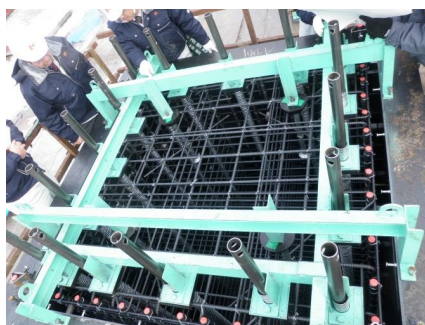
写真-5 照明塔柱型枠外観・上部状況
