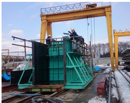
写真-3 標準柱型枠設置状況
