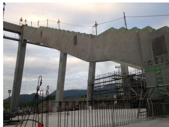
写真-18 大スパン架構緊張完了後
