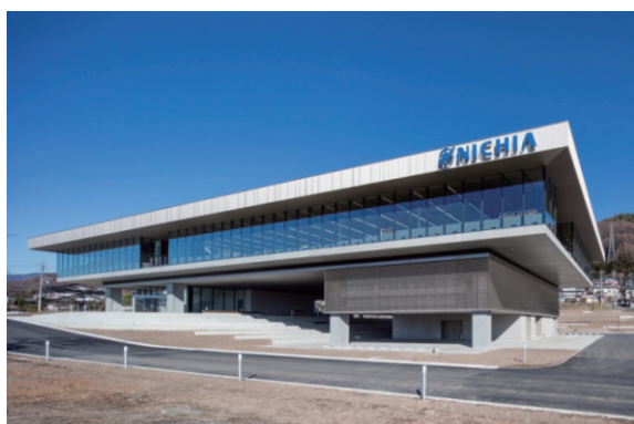
写真-1 外観写真
