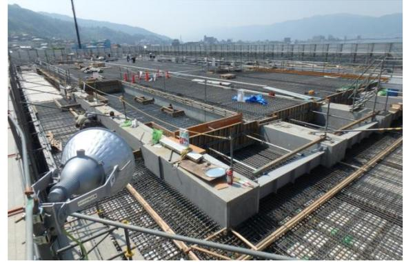
写真-9 床板配筋全景
