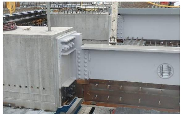
写真-7 PCaPC梁と鉄骨部材の取り合い
