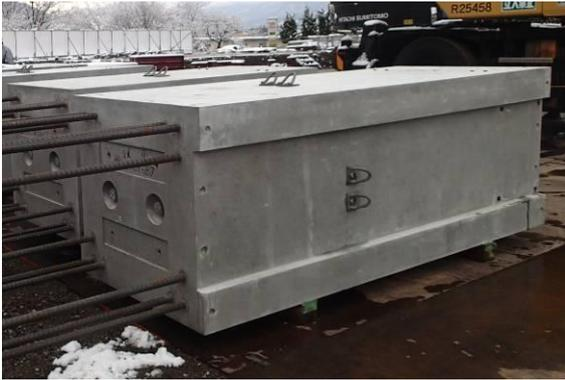
写真-3 柱部材の突起形状
