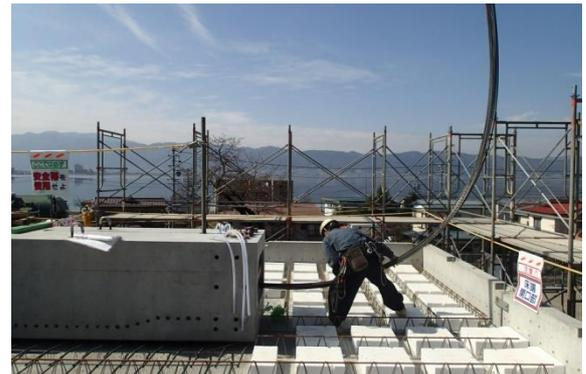
写真-11 PCケーブルの挿入状況
