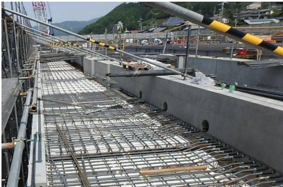
写真-10 PCaPC梁側面の定着筋
