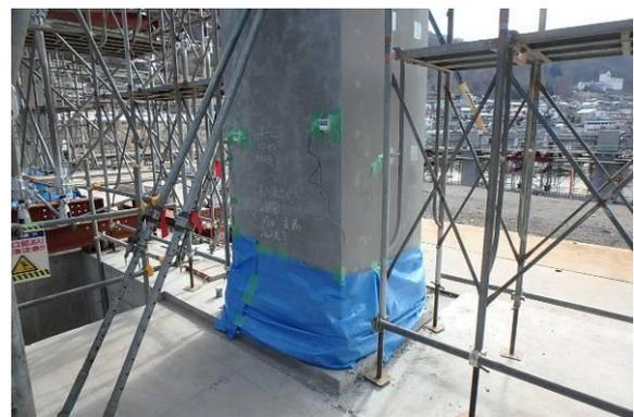
写真-6 PCa柱脚部採暖養生
