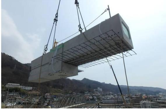
写真-8 PCaPC梁下端の定着筋
