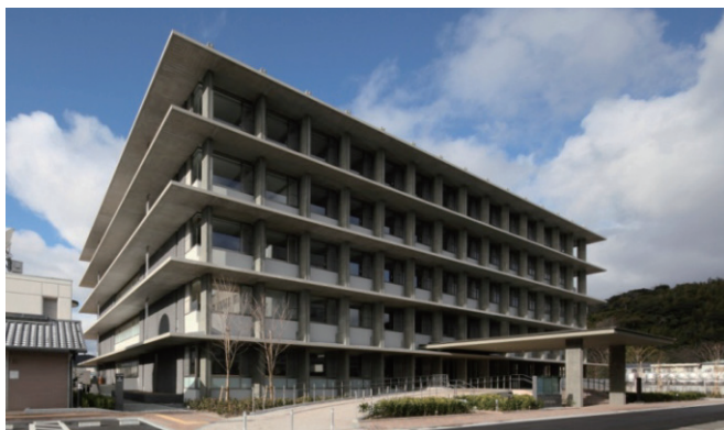
写真-1 新庁舎の外観（東面）
