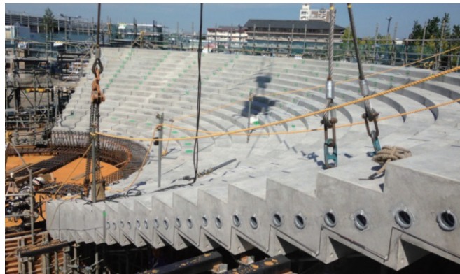
写真-4 古墳 A の架設状況
