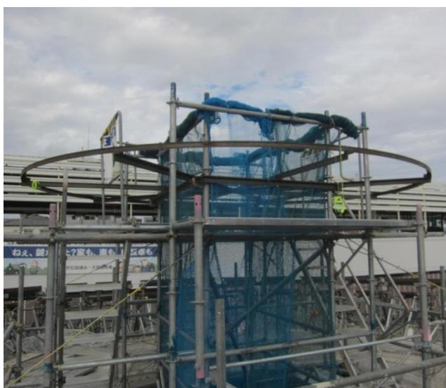
写真-10 基準アングル材の設置状況
