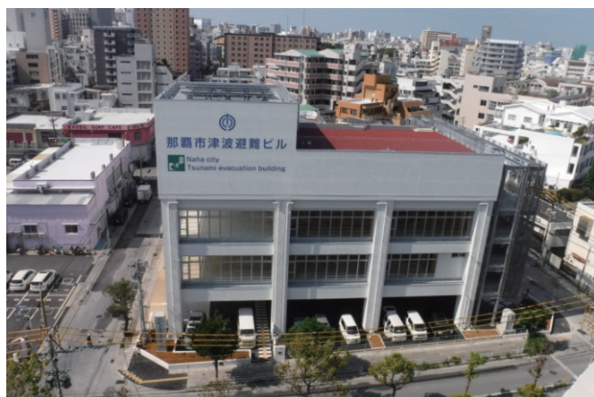
写真-1 完成写真
