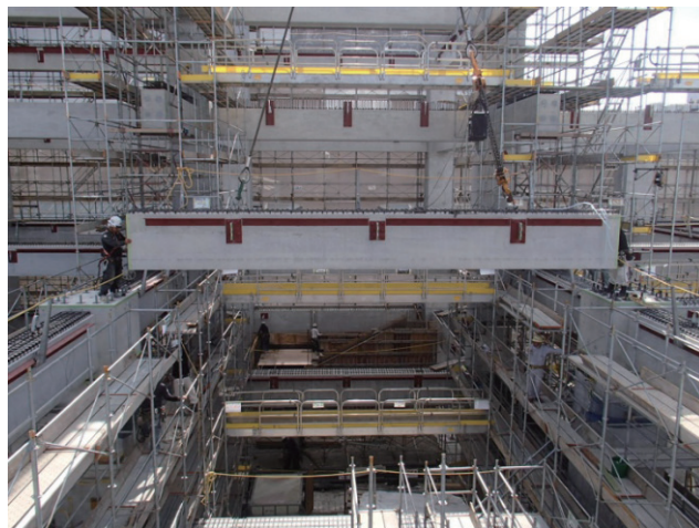
写真-4 架設状況
