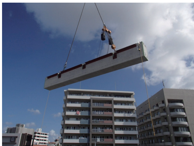
写真-3 鉄骨ベース及びデッキ受け先付け状況
