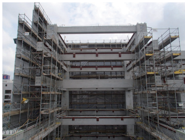
写真-5 架設状況
