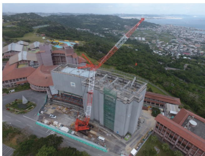
写真-1 施工状況
