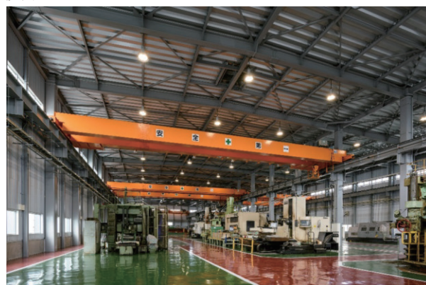
写真-3 竣工後内観
