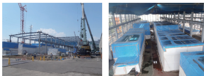
写真-2 施工写真
