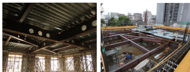
写真-2 食堂部施工状況
