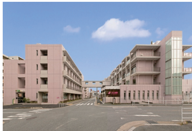
写真-1 本館・別館棟西側外観
