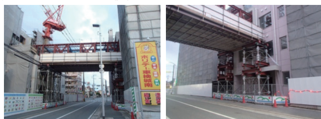
写真-2 RORO 支柱
