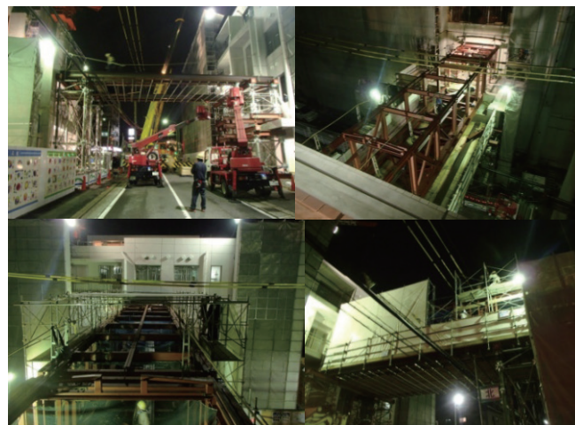
写真-3 上空通路架設状況
