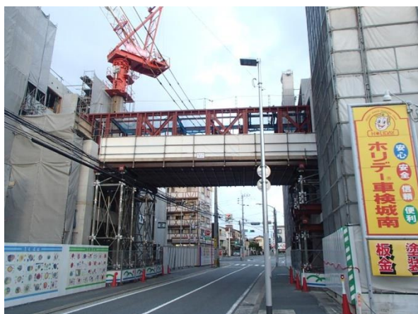
写真-3 本館棟 RORO 支柱
