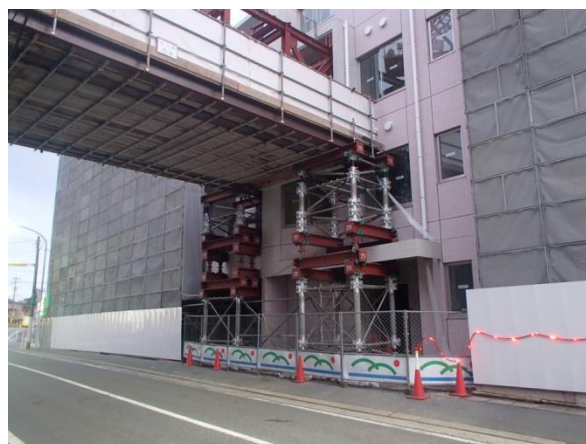
写真-4 別館棟 RORO 支柱
