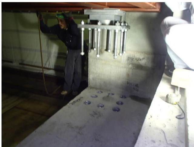
写真-5 すべり支承設置状況
