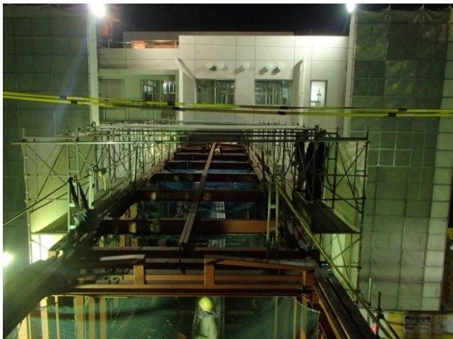
写真-8 架設状況
