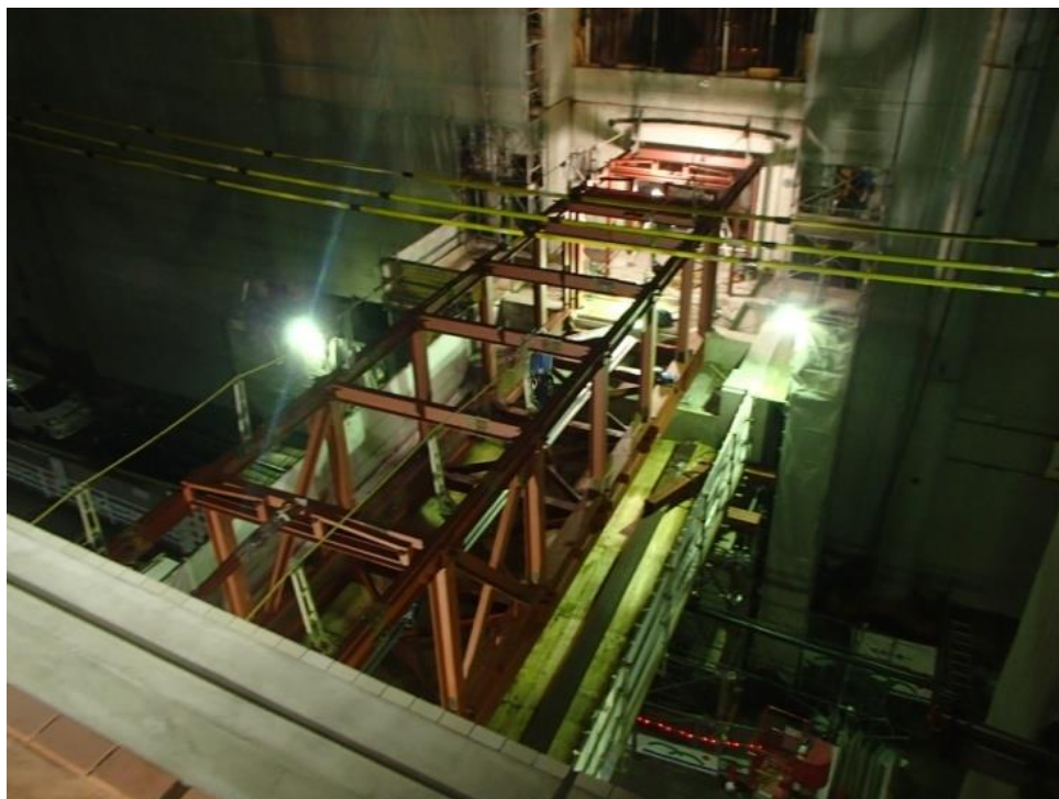
写真-7 架設状況
