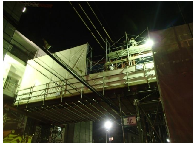
写真-9 架設状況
