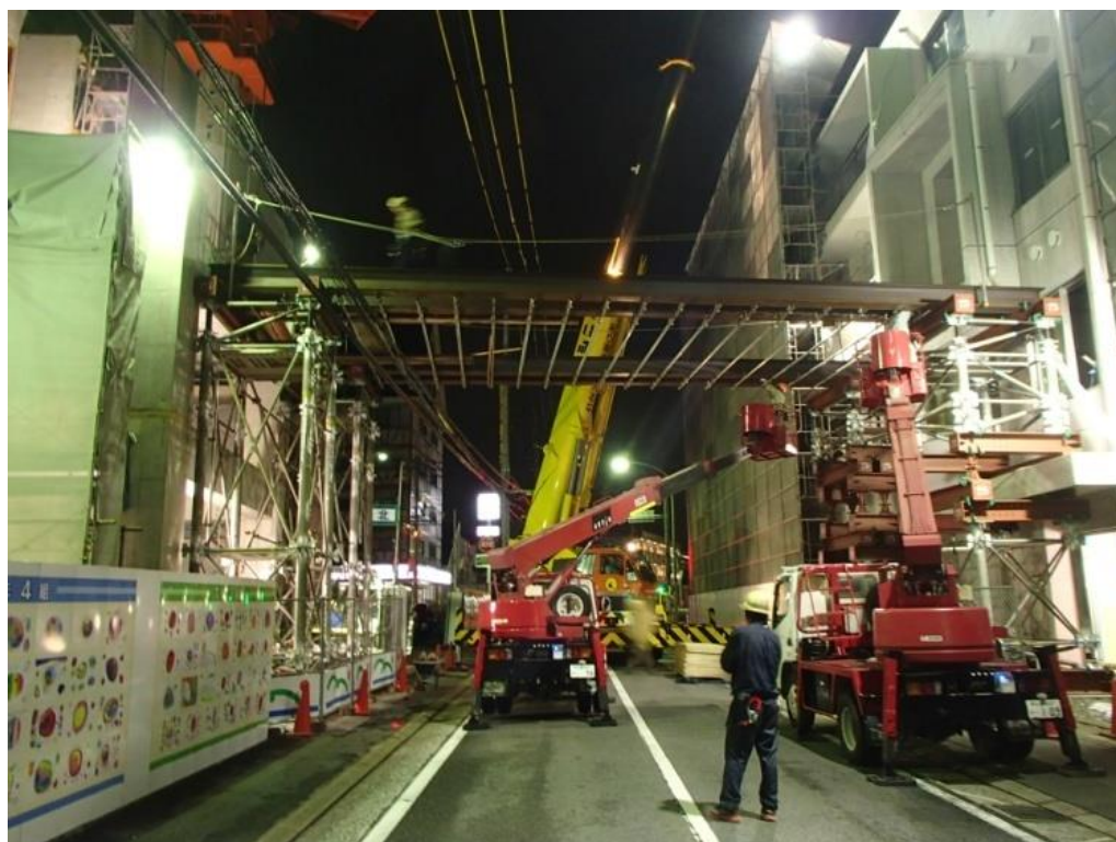
写真-6 架設状況
