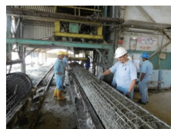
写真-7 コンクリート打設
