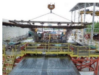
写真-11 コンクリート打設
