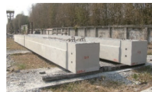
写真-14 PC ホロー桁
