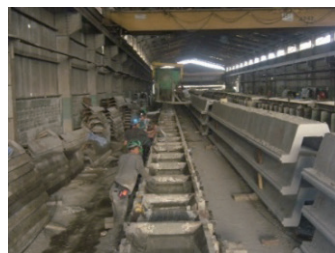
写真-9 コンクリート打設
