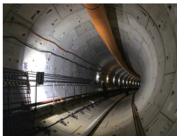
写真-3 トンネル内部
