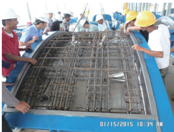
写真-1 鉄筋かごの設置
