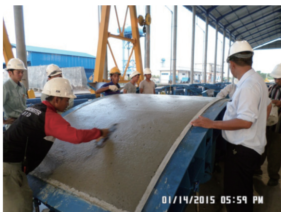
写真-2 コンクリート打設状況
