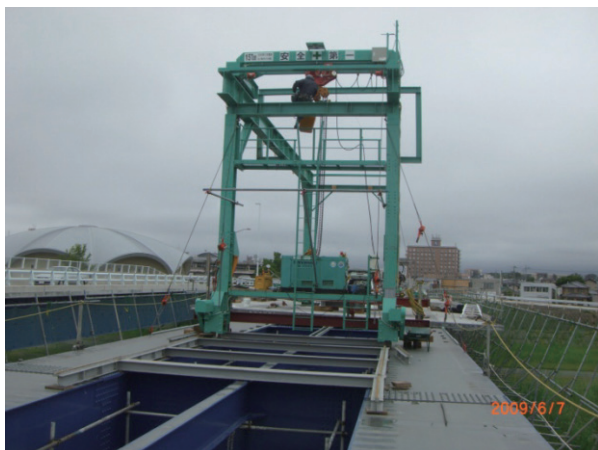
写真-2 同種架設機の施工事例(出羽大橋)
