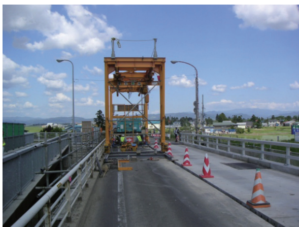
写真-1 同種架設機の施工事例(今泉橋)
