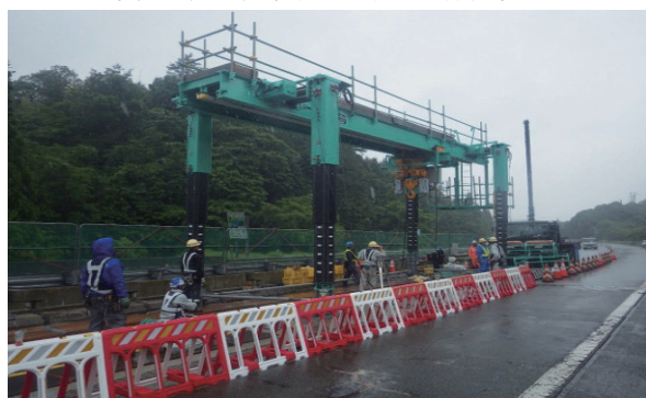
写真-6 架設機脚部の鉛直方向伸長状況
