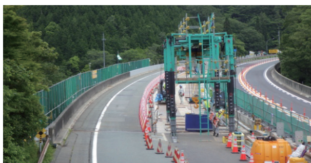
写真-7 架設機の設置完了状況
