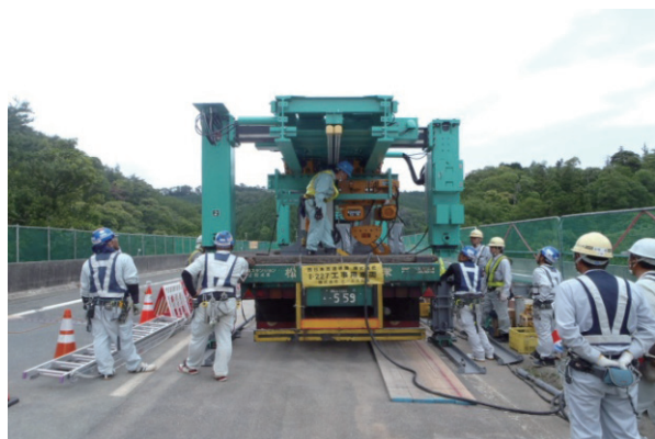
写真-5 架設機脚部の水平方向伸長状況
