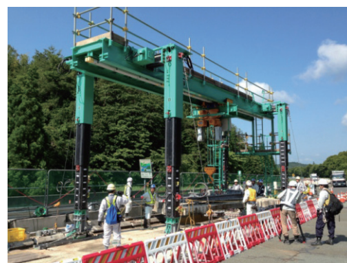
写真-9 床版の架設状況
