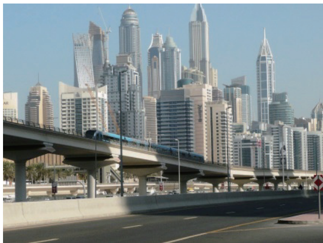
写真-6 ドバイメトロ高架橋と高層ビル群
