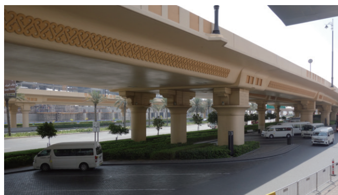
写真-8 高速道路の高架橋
