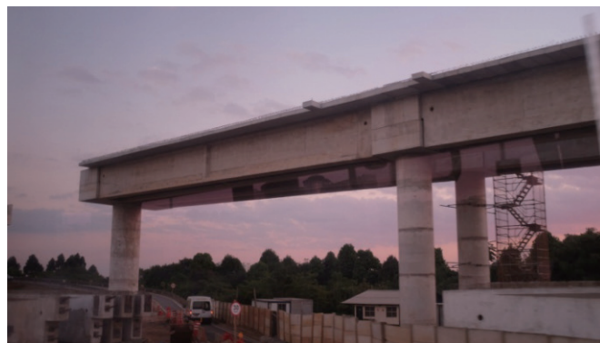
写真-7 建設中のコンクリート橋
