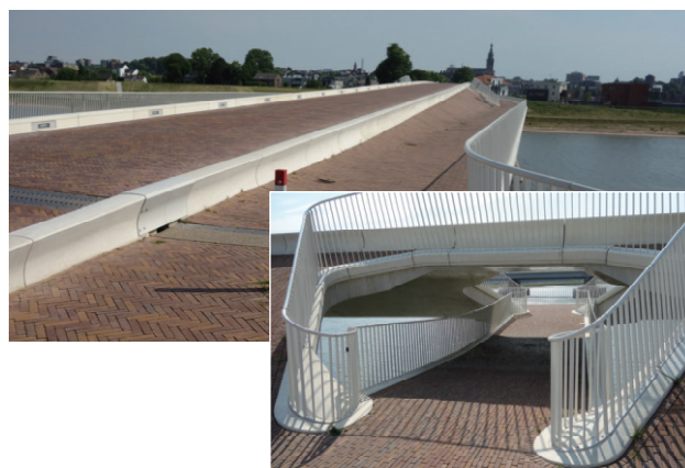
写真-8 ナイメーヘン橋（橋面上から撮影）
