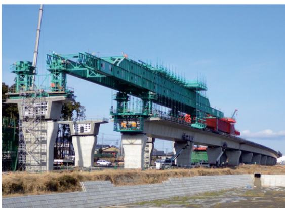
写真-1 施工状況
