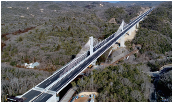
写真-1 生野大橋全景
