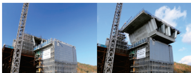
写真-3 押出し架設施工状況
