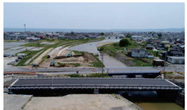
写真-2 工事完成写真
