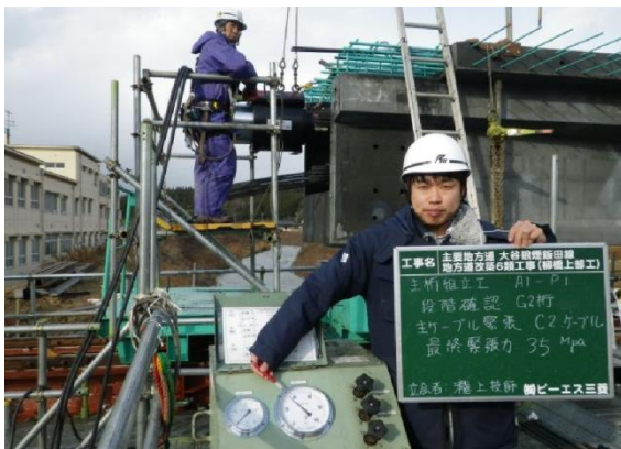
写真-2 主ケーブル同時緊張状況（P1側）
