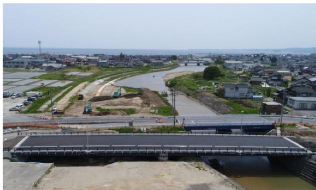
写真-4 工事完成写真 1
