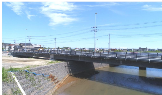
写真-5 工事完成写真 2
