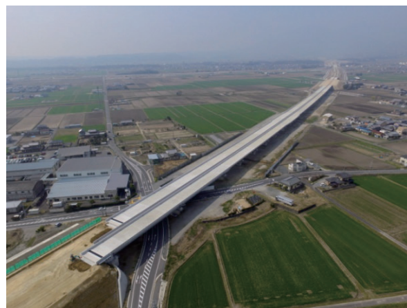
写真-1 工事完成写真
