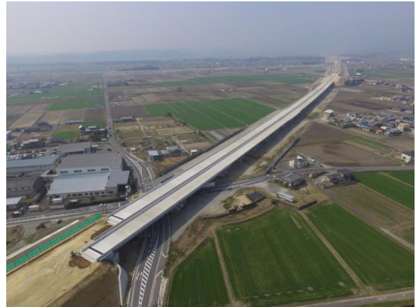
写真-2 工事完成写真
