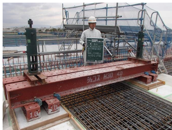
写真-1 固定鋼材設置状況
