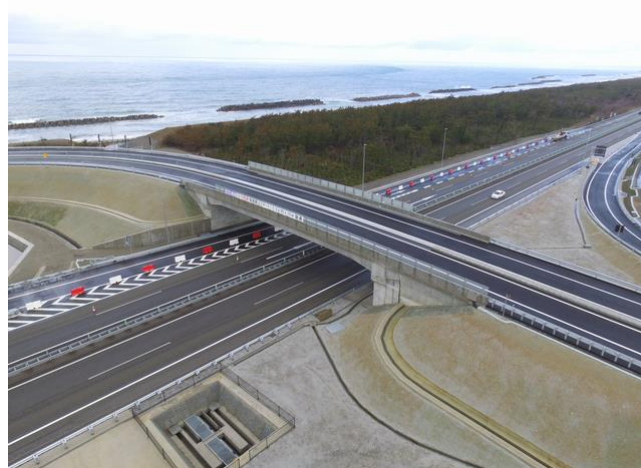
写真-3 完成写真
