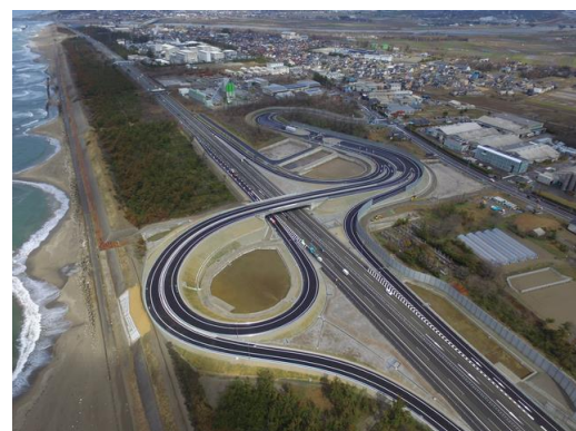
写真-1 インターチェンジ全景
