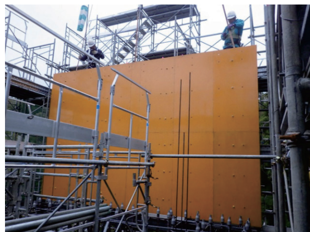
写真-3 パネル型枠吊り下し状況
