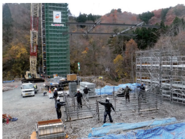
写真-2 鉄筋地組み状況 吊り上げ
