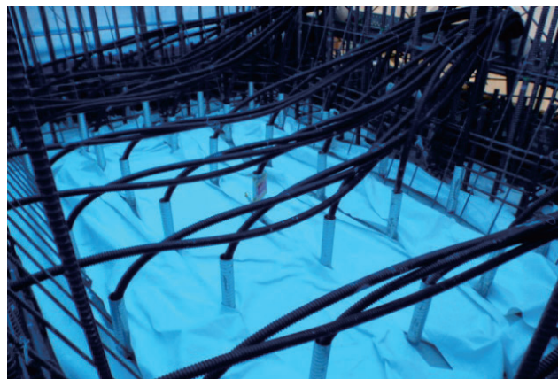
写真-4 空冷クーリング状況
