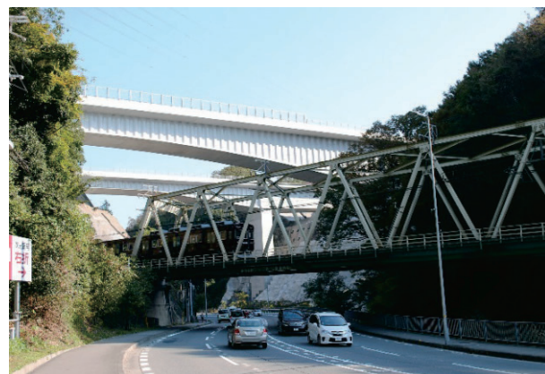
写真-1 完成写真
