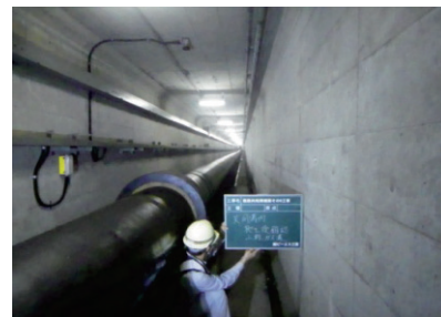
写真-1 共同溝(ガス溝)調査
