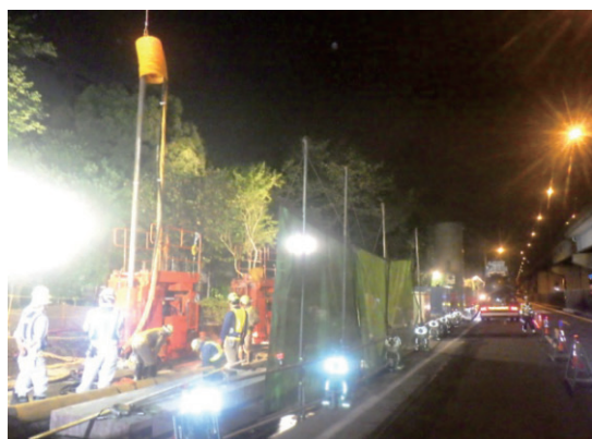
写真-2 改良状況全景
