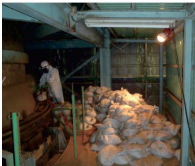
写真-2 人力による灰出し作業状況
