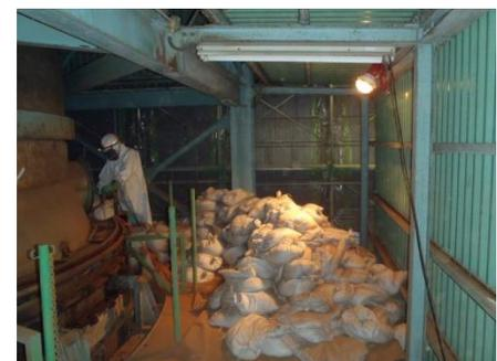
写真-3 人力による灰出し作業状況
