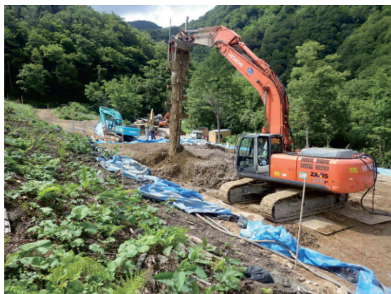
写真-1 パワーブレンダー工施工状況
