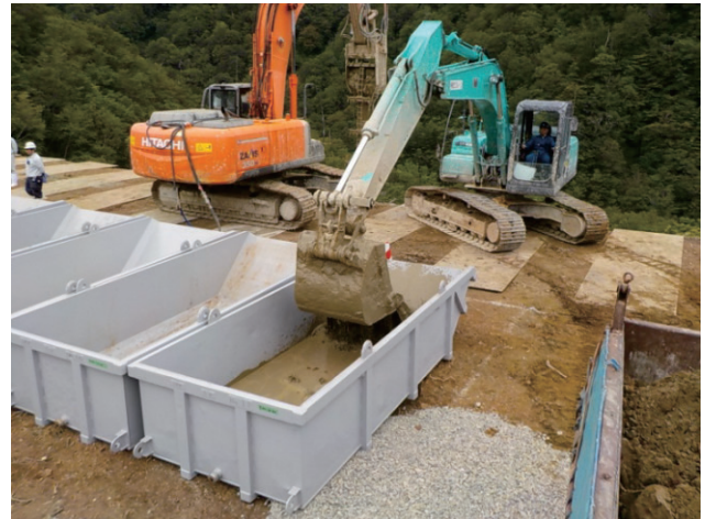
写真-3 改良土硬化確認試験
