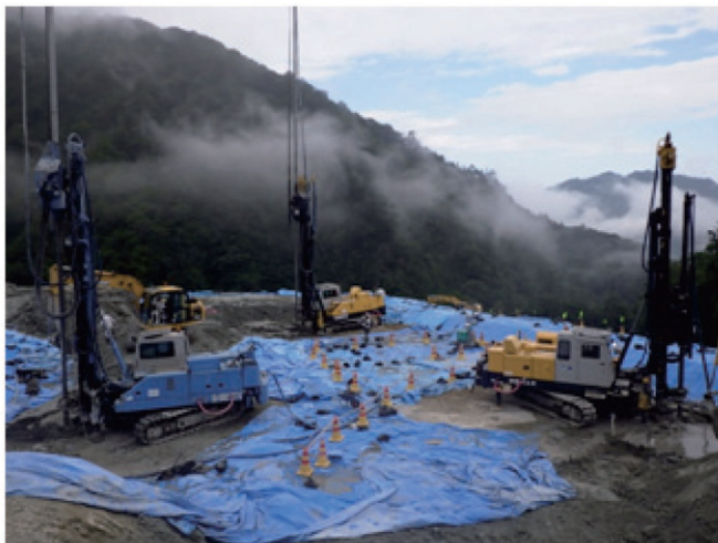
写真-2 ミニコラム工施工状況
