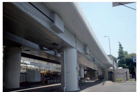
写真-3 外ケーブル配置状況
