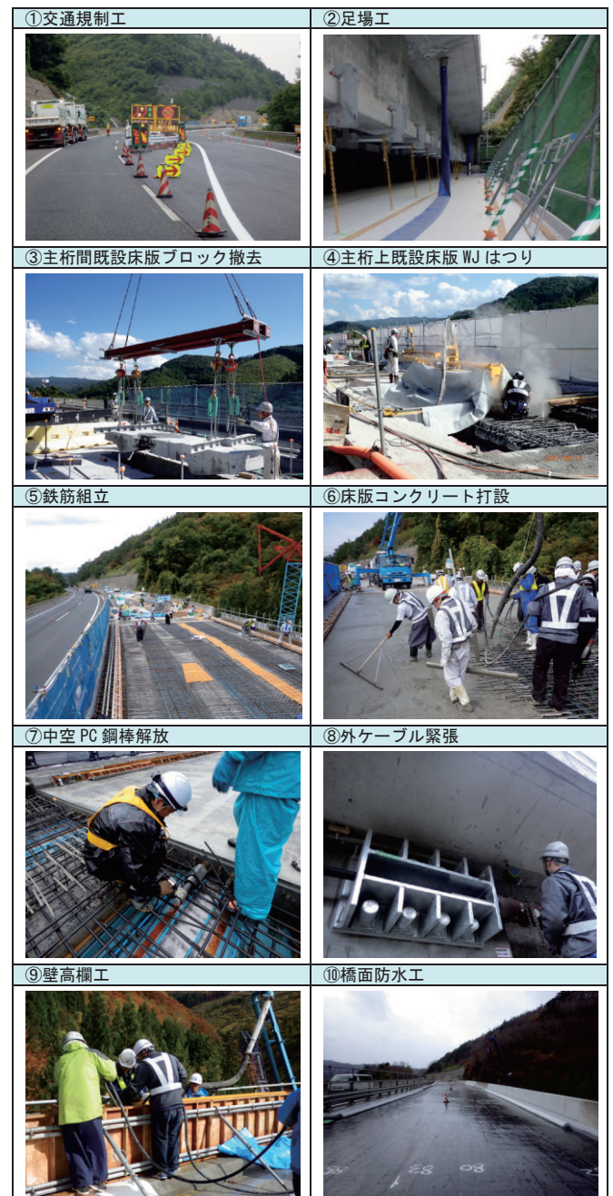
図-6 施工概要写真
