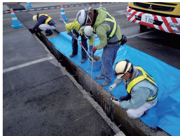
写真-6 防錆材塗布状況
