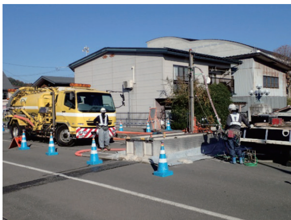
写真-5 ウォータージェット工法によるはつり状況
