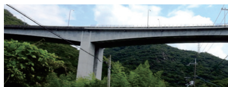
写真-1 主ケーブルに PC 鋼棒を使用した箱桁橋の一例
