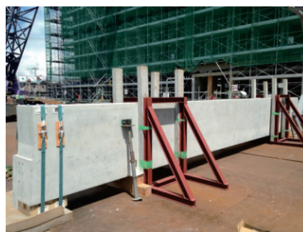
写真-3 仮置き状況
