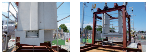
写真-2 モックアップ設置状況
