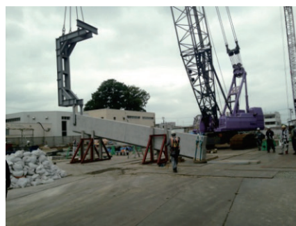
写真-4 建て起こし状況
