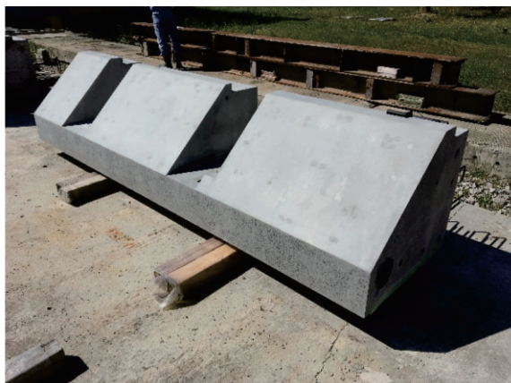
写真-3 PCaRC 袖壁部材
