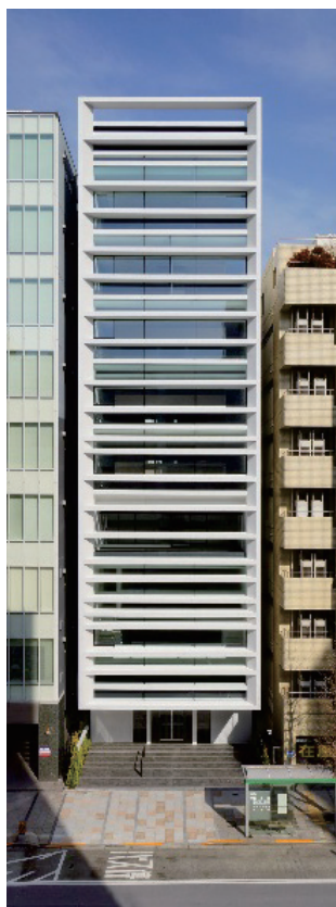
写真-1 建物外観
