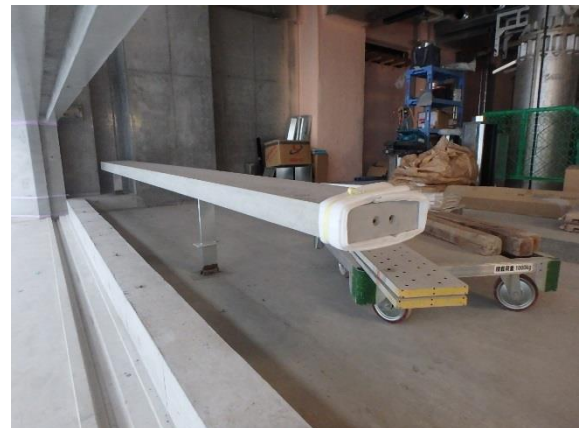
写真-15 PCaPC ベンチ設置状況
