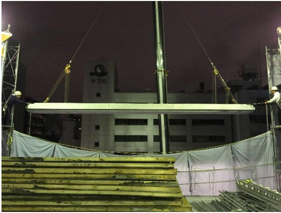
写真-9 底部材の楊重
