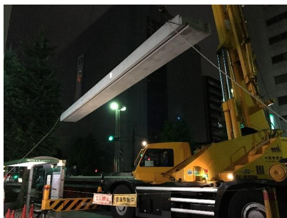
写真-8 底部材の地切り
