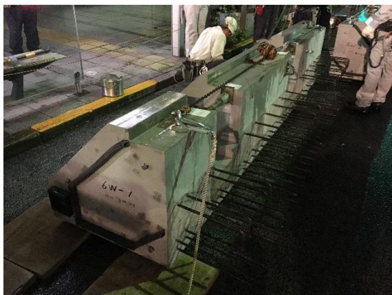
写真-7 袖壁部材の楊重
