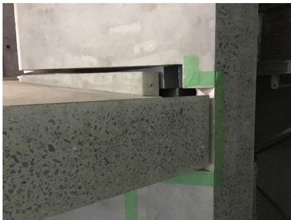
写真-11 底と袖壁の収まり
