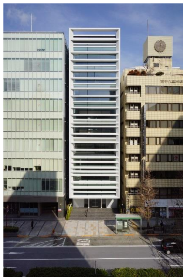
写真-1 建物外観（正面）
