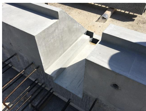
写真-5 袖壁切り欠き部
