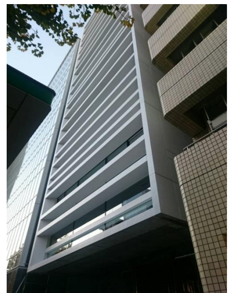
写真-2 建物外観（見上げ）
