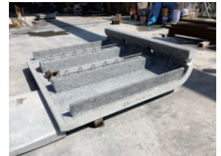
写真-4 嵩上げコンクリート仮置き状況 写真-5 笠コンクリート仮置き状況
