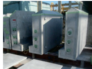
写真-4 嵩上げコンクリート仮置き状況 写真-5 笠コンクリート仮置き状況
