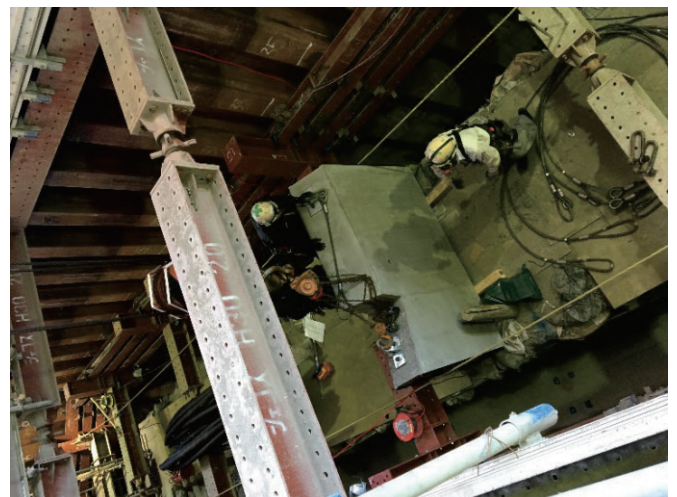
写真-6 嵩上げコンクリート部材架設状況
