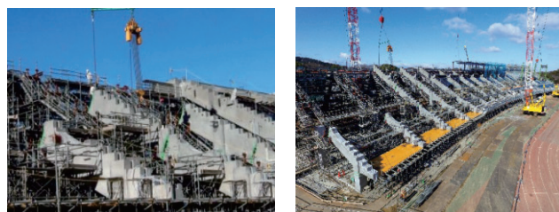
写真-5 PCa段梁架設状況
