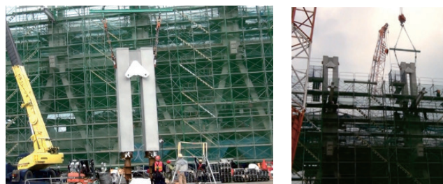
写真-3 門形柱の建方状況
