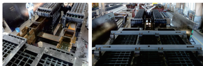
写真-2 製作状況（鉄骨接合）
