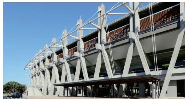
写真-1 建物外観
