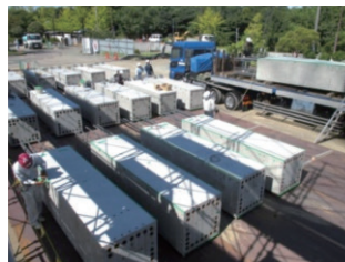
写真-2 PCa部材先行搬入
