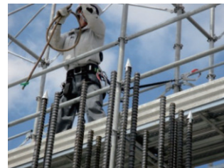
写真-3 柱頭鉄筋先端部
