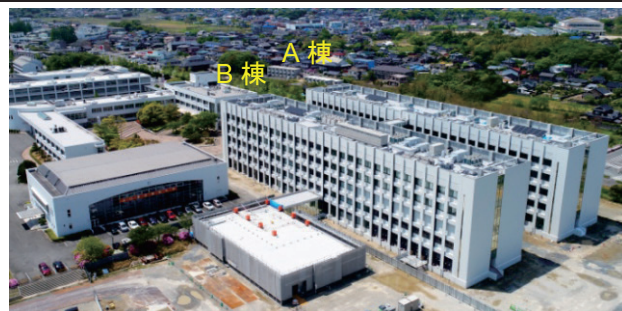
写真-1 建物外観
