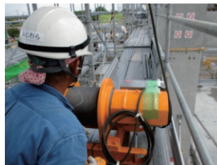
写真-4 長辺方向のPC鋼線入線状況
