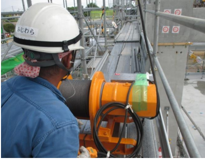
写真-21 ウインチによる入線
