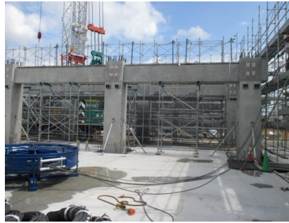
写真-22 ターンテーブル設置
