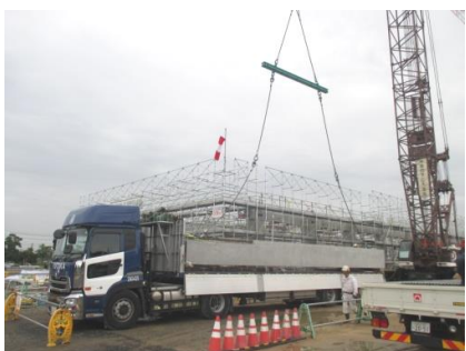
写真-15 スパン梁搬入状況
