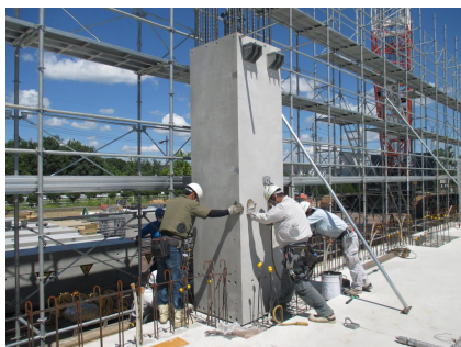
写真-10 柱架設状況
