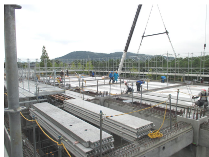
写真-19 敷設状況
