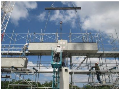
写真-12 レンコン梁架設状況
