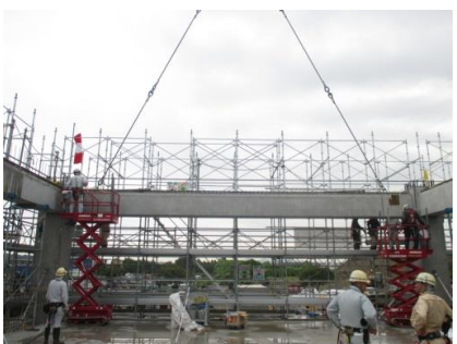
写真-16 スパン梁架設状況
