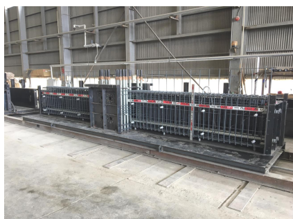
写真-4 レンコン梁(配筋)
