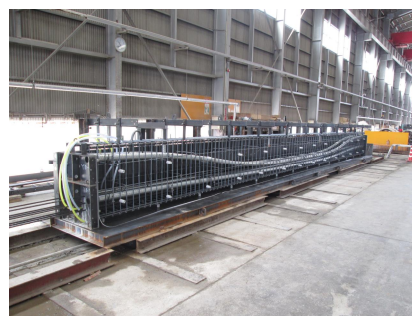
写真-5 スパン梁(配筋)
