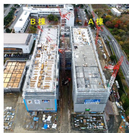
写真-2 建設状況
