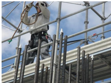
写真-13 柱頭鉄筋先端部
