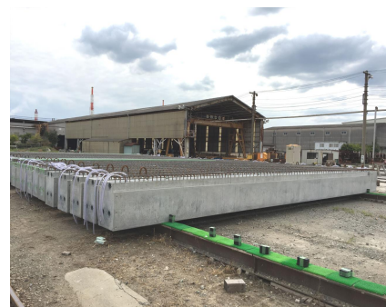
写真-8 スパン梁(出来型)
