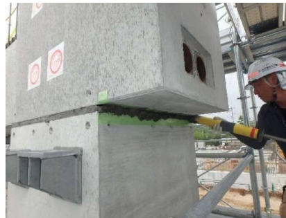
写真-14 水平目地部モルタル型枠
