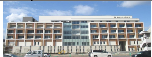
写真-1 建物外観
