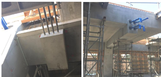
写真-2 PCaPC 梁底増打ち部分の施工状況
