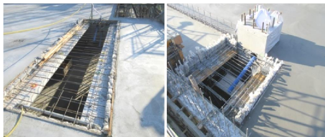
写真-3 緊張端部の後施工状況
