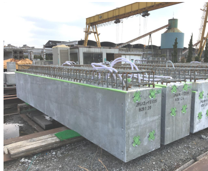
写真-6 PCaPC 桁梁
