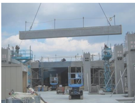
写真-18 スパン梁架設状況
