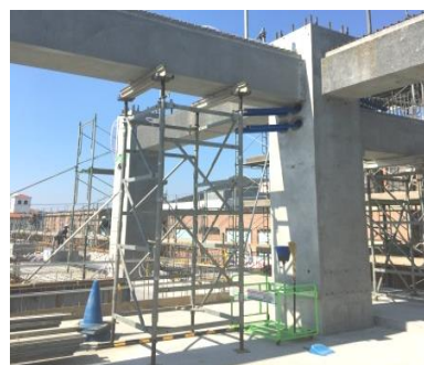
写真-19 梁受け用支保工
