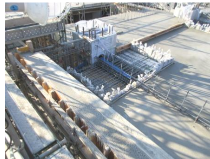
写真-25 後施工固定端部
