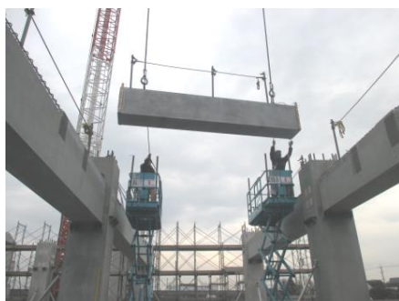
写真-17 桁梁架設状況
