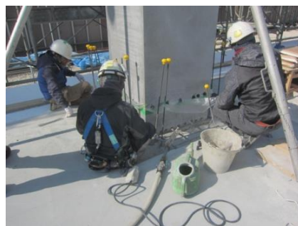
写真-16 モルタル注入状況
