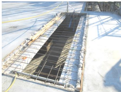
写真-23 後施工スパンクリート部
