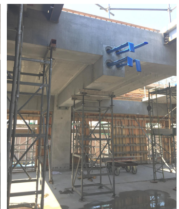
写真-10 梁底増打ち部②
