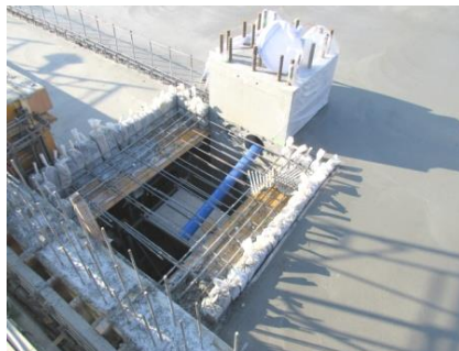
写真-24 後施工緊張端部
