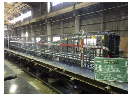
写真-13 スパン梁配筋状況
