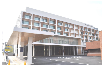
写真-2 新病院の外観(北面)
