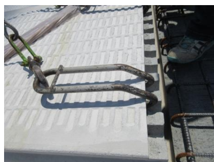
写真-22 敷設用治具
