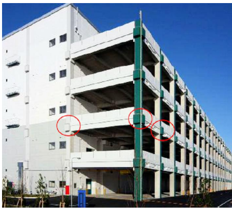
写真-8 定着体突起の例
