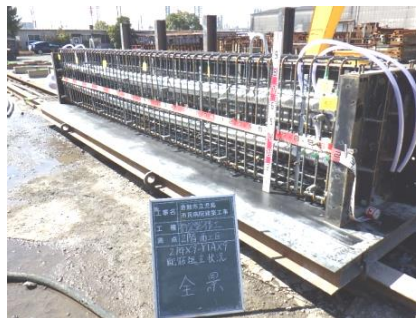
写真-12 桁梁配筋状況
