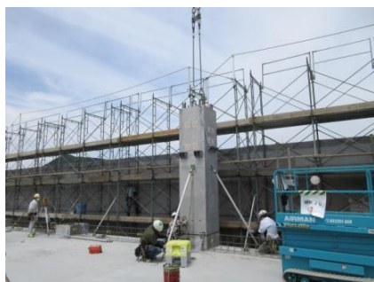
写真-14 柱架設状況
