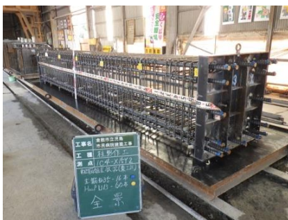
写真-11 柱配筋状況
