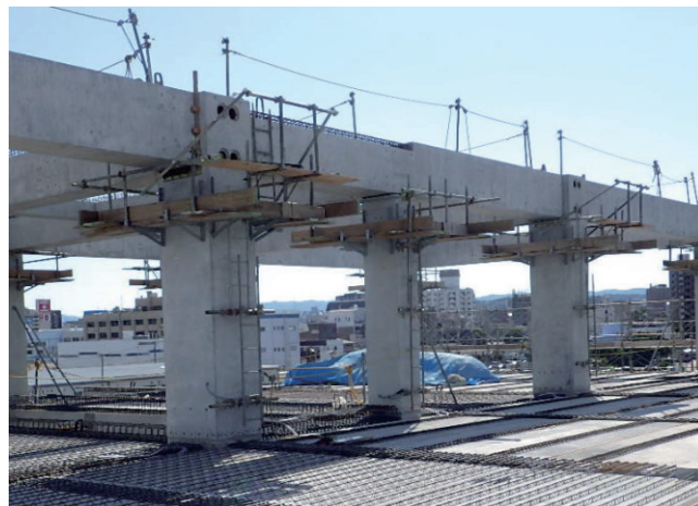
写真-1 上層階の仮設足場
