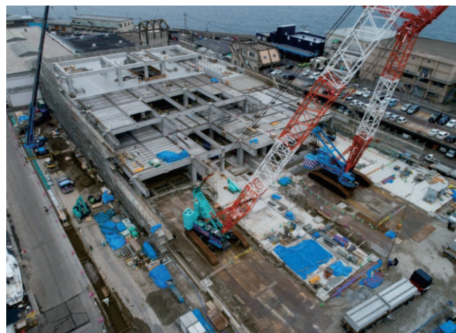
写真-2 施工状況
