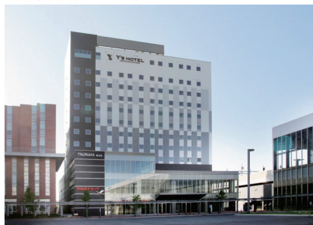
写真-1 建物外観
