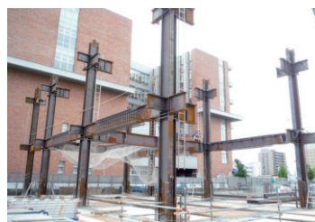
写真-4 鉄骨建方状況
