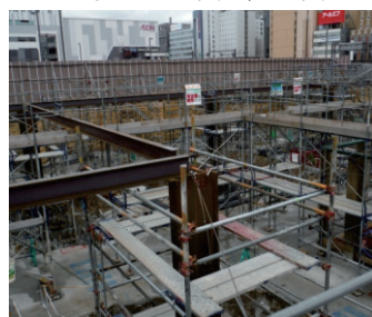
写真-2 0節鉄骨建方状況
