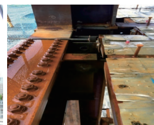
写真-5 外周梁デッキ取合い
