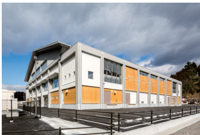
写真-2 建物外観（東西面）
