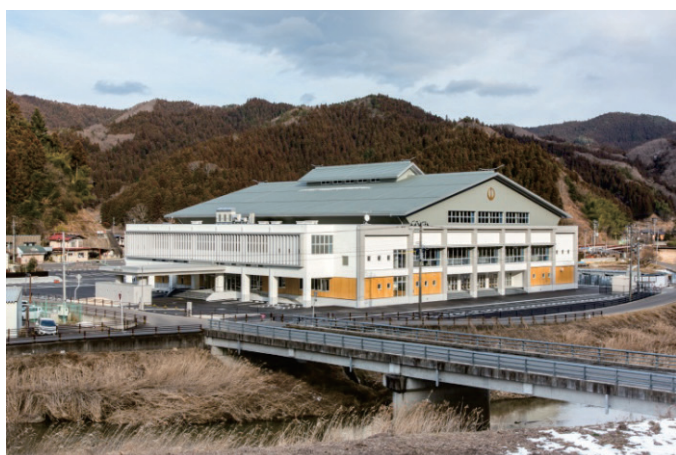
写真-1 建物外観（南西面）
